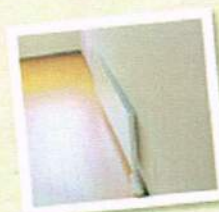
※パネルヒーター
